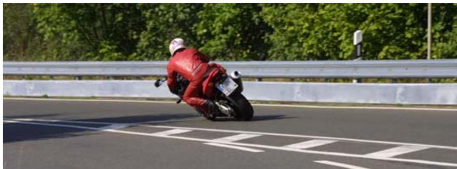
Herkömmliche Leitplanken sind so konstruiert, dass die eigentliche Abprall-Planke in Höhe der Motorhaube eines durchschnittlichen Pkws angebracht ist. Der verbleibende Abstand zum Boden birgt die Gefahr, dass ein stürzender Zweiradfahrer sich an der Leitplanke oder dem Stützpfeiler schwer oder gar tödlich verletzt.
