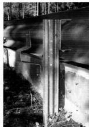
Der lebensrettende Unterfahrschutz inklusive aller Montageteile ist feuerverzinkt.
