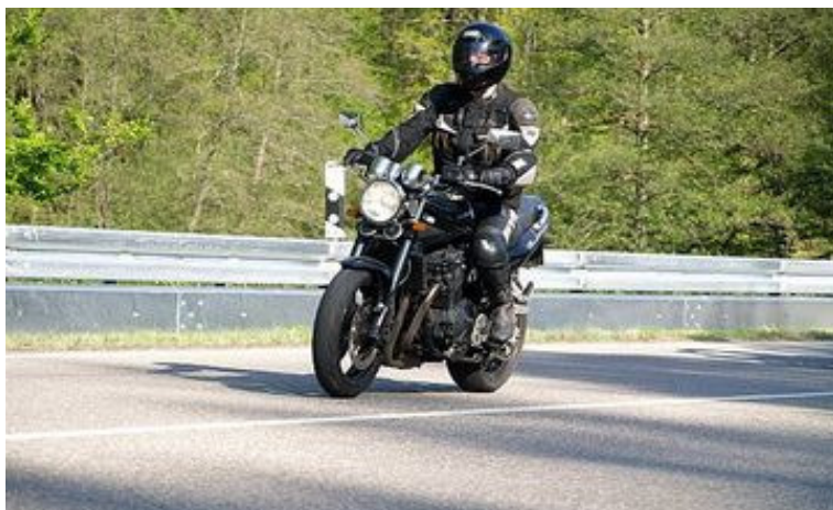
Blech unter der Leitplanke: Der Unterfahrschutz soll schwere Verletzungen bei Stürzen von Motorradfahrern verhindern.
