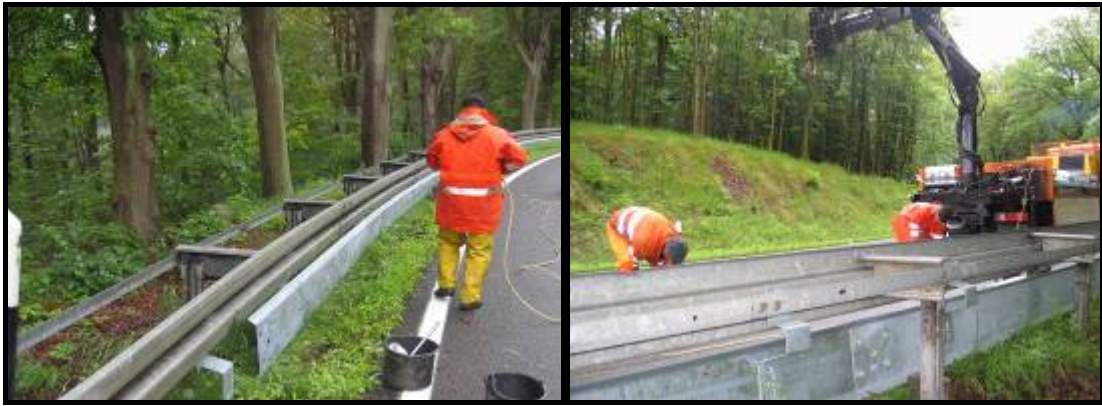
Montage des Unterfahrschutzes im Bereich B 27 am 29.05.2007
