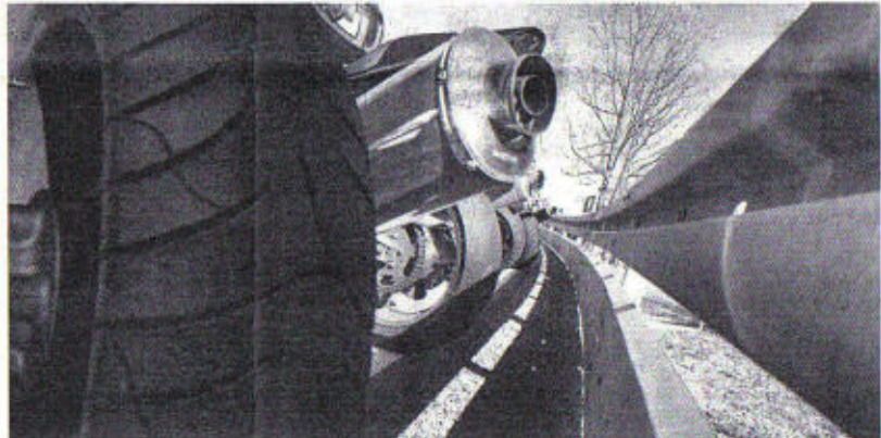
Der Leitplanke ist unten geschlossen, damit sie nicht zur Todesfalle wird. Foto Steffen Honzera
