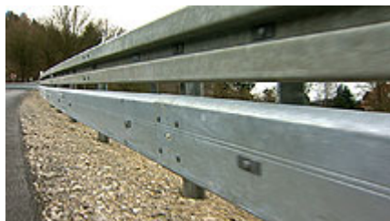
Leitplanke mit Unterfahrschutz
