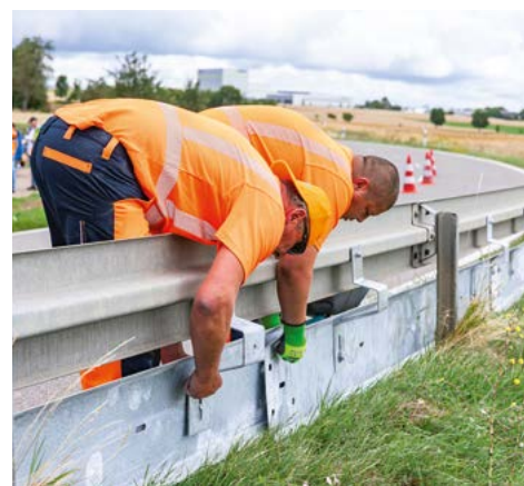
Men at work: Jazek Kodlowski und Sascha Ilin beim Fixieren eines Unterfahrschutzes. Damit der Unterfahrschutz seine Wirkung entfalten kann, wird er nach dem Fixieren noch einige Zentimeter nach oben ausgerichtet. Der Unterfahrschutz schwebt dann zwischen Straße und Leitplanke und absorbiert dadurch Aufprallenergie.
