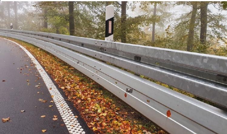
Dieser durch MEHRSi initiierte Unterfahrschutz entschärft einen weiteren Unfallschwerpunkt und kann zukünftig Leben retten.
