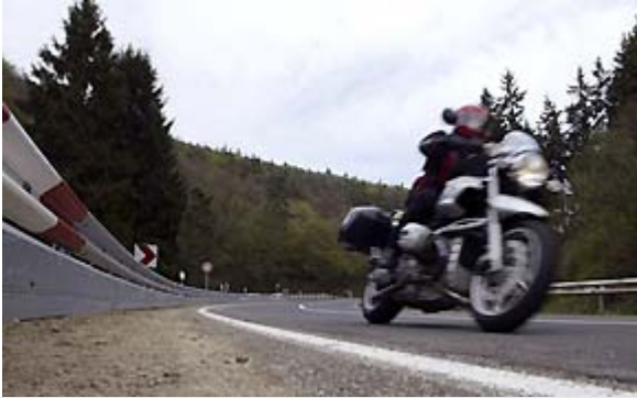
Einfach nachzurüsten und doch effektiv: Unterfahrschutz an Leitplanken.
