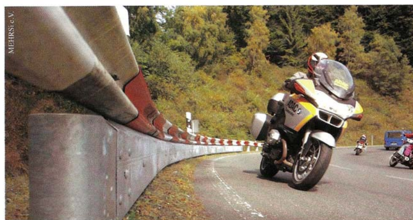
Biker im Visier: Ein federnd aufgehängter Unterfahrschutz senkt das Verletzungsrisiko erheblich.
