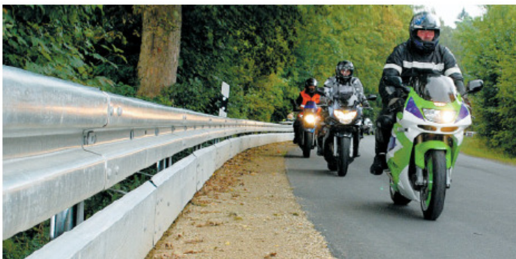
Lebensrettende Barriere: Die federnd angebrachte Stahlplanke absorbiert im Falle einer Kollision die Aufprallenergie und verhindert ein Durchrutschen des gestürzten Kradfahrers.
