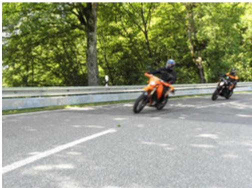
**HAUSEN IM TAL (bh) - Bei 37 Kurven im Kreisgebiet sind insgesamt 3800 Meter Unterfahrschutz an den Leitplanken angebracht worden. Die federnden Metallplatten sollen die Aufprallenergie auffangen und ein Unterfahren der in Autohöhe montierten Leitplanken verhindern. Jetzt wurden diese Neuerungen im Donautal der Öffentlichkeit vorgestellt.**
