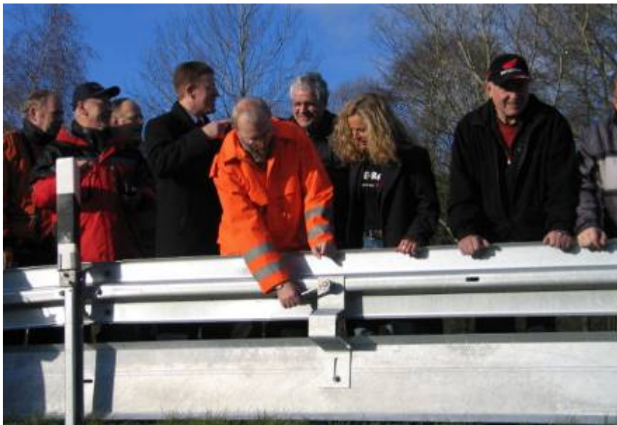
Rüdiger Kranz vom ASV Bad Arolsen montiert den letzten Meter
