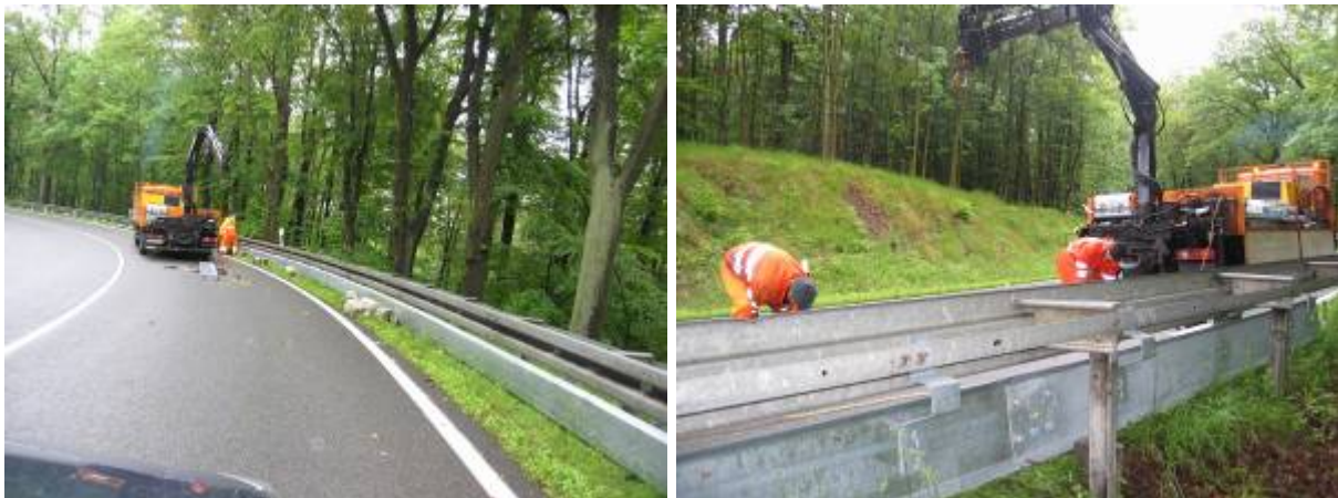
Montage des Unterfahrschutzes im Bereich der B 27
